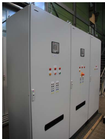
Impressionen aus dem SGT Lab: links Verteilerschrank Mitte: AC und DC Verteilerschränke
